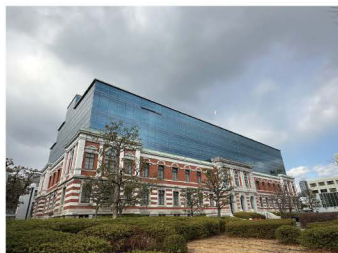
神戸地方裁判所庁舎 ハーフミラーのカーテンウォールで増築部分の存在を消した、草創期のひとつ。
