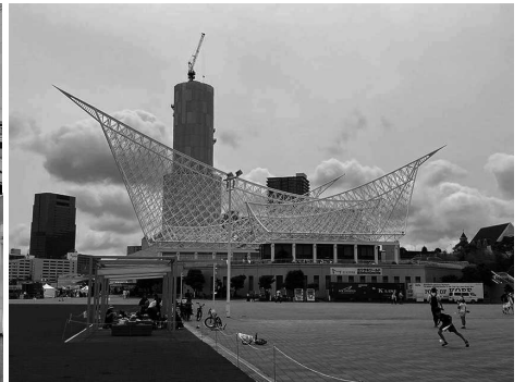
海洋博物館と改修工事中のポートタワー
